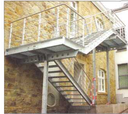
Von Toren über Treppen bis hin zu Fertigbalkonen und Kunstschmiedearbeiten – die Bauschlosserei Tiemann verfügt über ein weites Portfolio.
